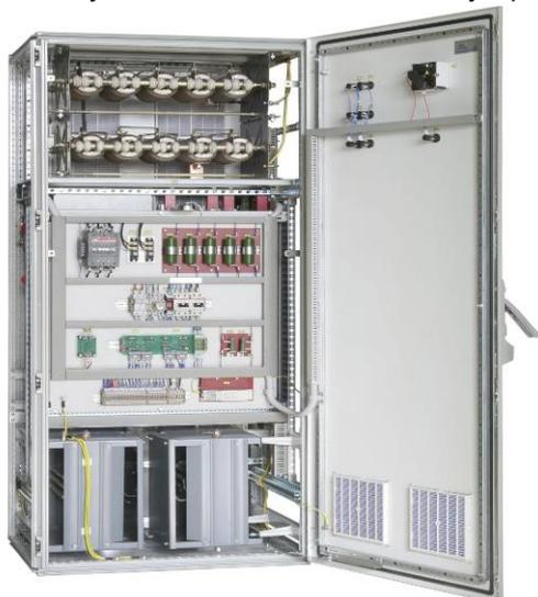
от 0,8 до 1,1  $U_n$ , задатчик интенсивности, регуляторы напряжения и тока возбуждения генератора. Регуляторы тока и напряжения генератора – пропорционально-интегральные.
